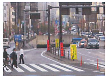
築地虎ノ門トンネル(新橋から)
