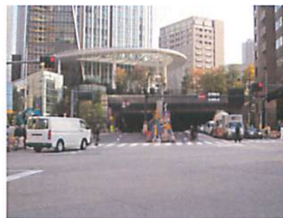
築地虎ノ門トンネル(虎ノ門から)
