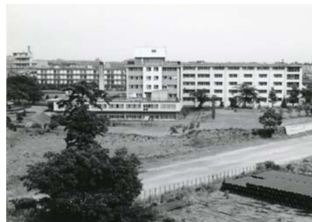
昭和49年 R246工事中
